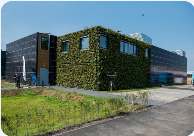
Datenwachstum und Nachhaltigkeit im Einklang: Das NetCologne-Rechenzentrum in Köln ist Best Practice für eine neue Generation lokaler Rechenzentren.
